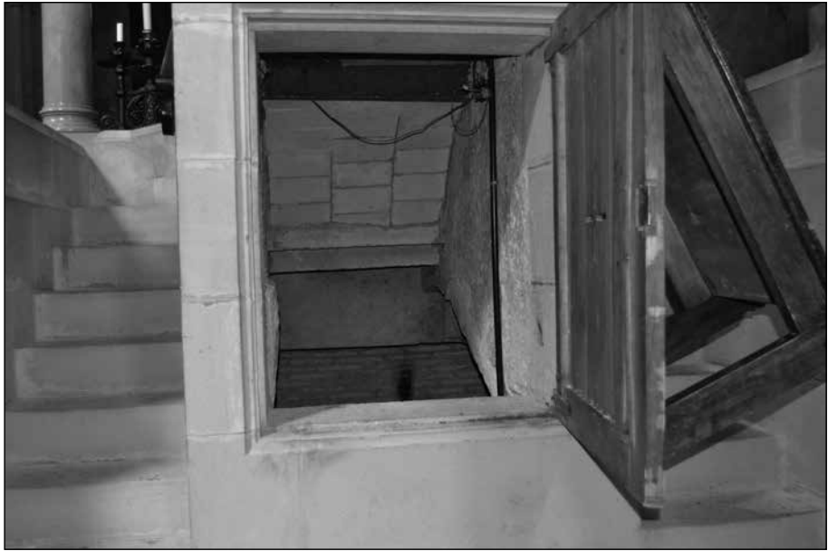
Porta actual d'entrada a la Cripta.
