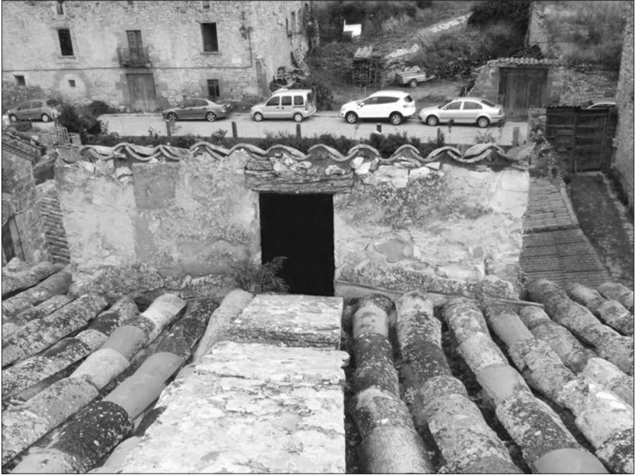
Foto núm. 4. La petita finestra que, des de la torre, dóna accés a la teulada de la nau central de l'església.
