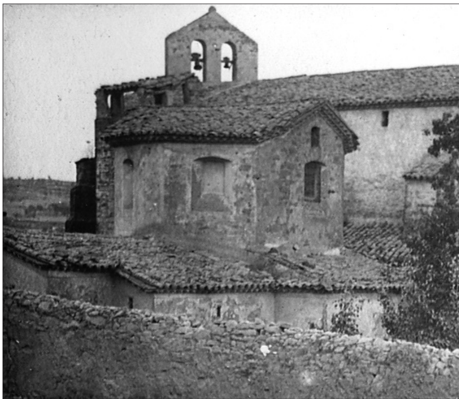
Foto núm. 3. Antiga torre que creiem que havia estat el primitiu campanar del convent.
